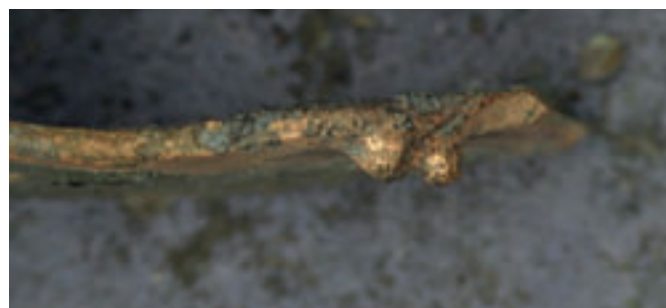
Bild 3 | Schmelzperle an einer elektrischen Kupferleitung.
