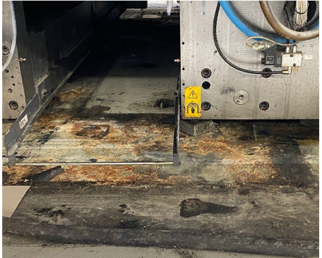
Abb. 2: Extreme Verschmutzungen mit Korrosionsprodukten unterhalb der Druckwerke.
