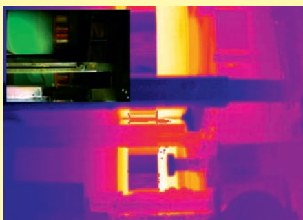
Infrarotbild mit rot markierten Bereichen für deutliche Überhitzungen durch zu hohe Reibung. Oberes Bild (1.) zeigt reale Verhältnisse.
