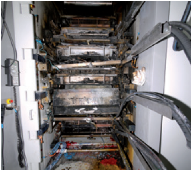
Im Bereich der Druckwerke 1 bis 5 zeigen sich starke Verbrennspuren.
