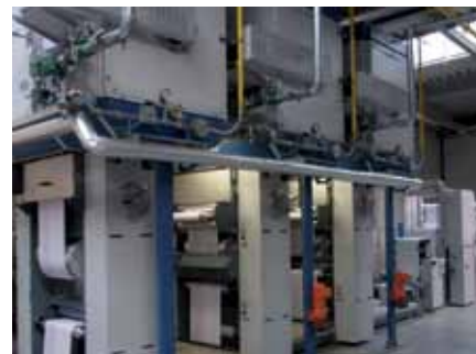
Zweifarbige Rotations-siebdruckmaschine Bei der zu prüfenden Anlage handelt es sich um eine zweifarbige Rotations-siebdruckmaschine mit Zwischentrocknung nach dem ersten Druckwerk und Endtrocknung nach dem zweiten Druckwerk.
